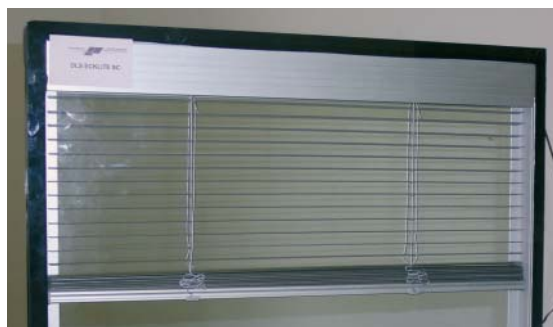
Store intégré dans la fenêtre. Lorsqu'il est baissé, même si les lamelles sont en position horizontale, il protège en partie contre des collisions.
