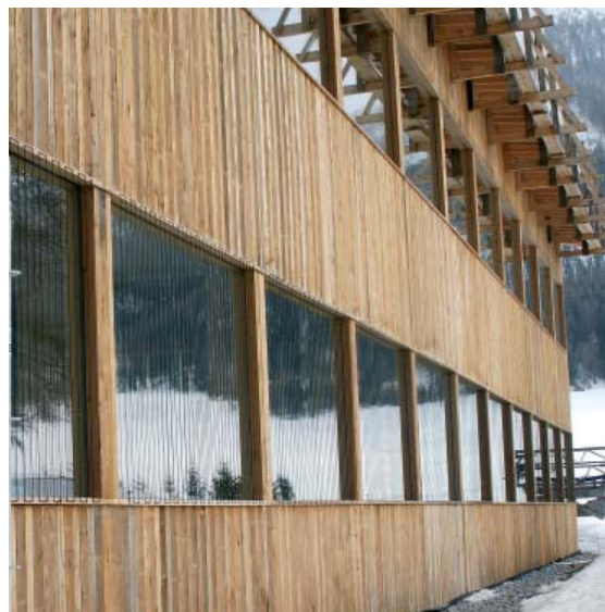
Une solution efficace et bon marché : fils en nylon noirs tendus verticalement.
