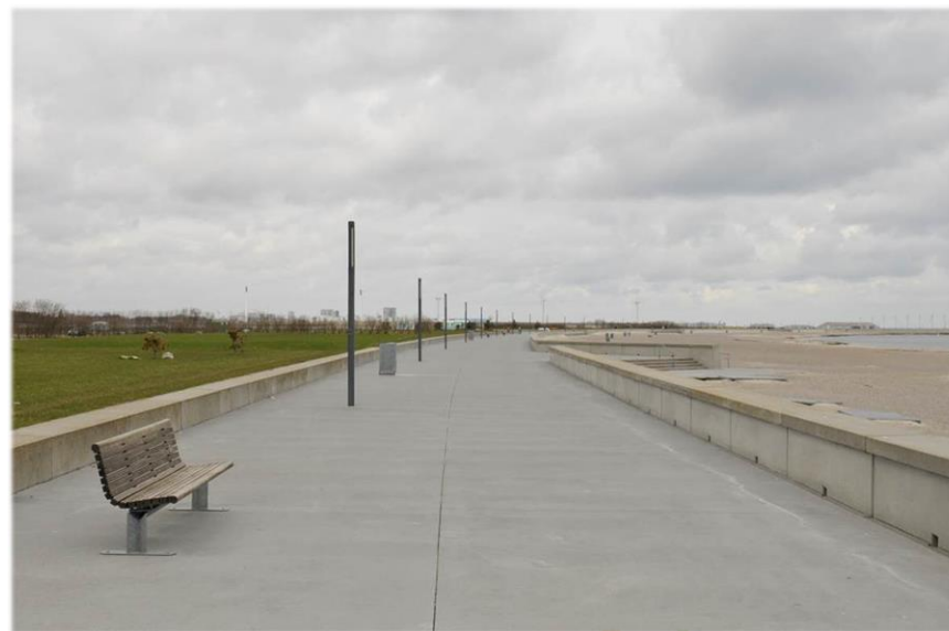
Digue et espaces verts du front de mer
