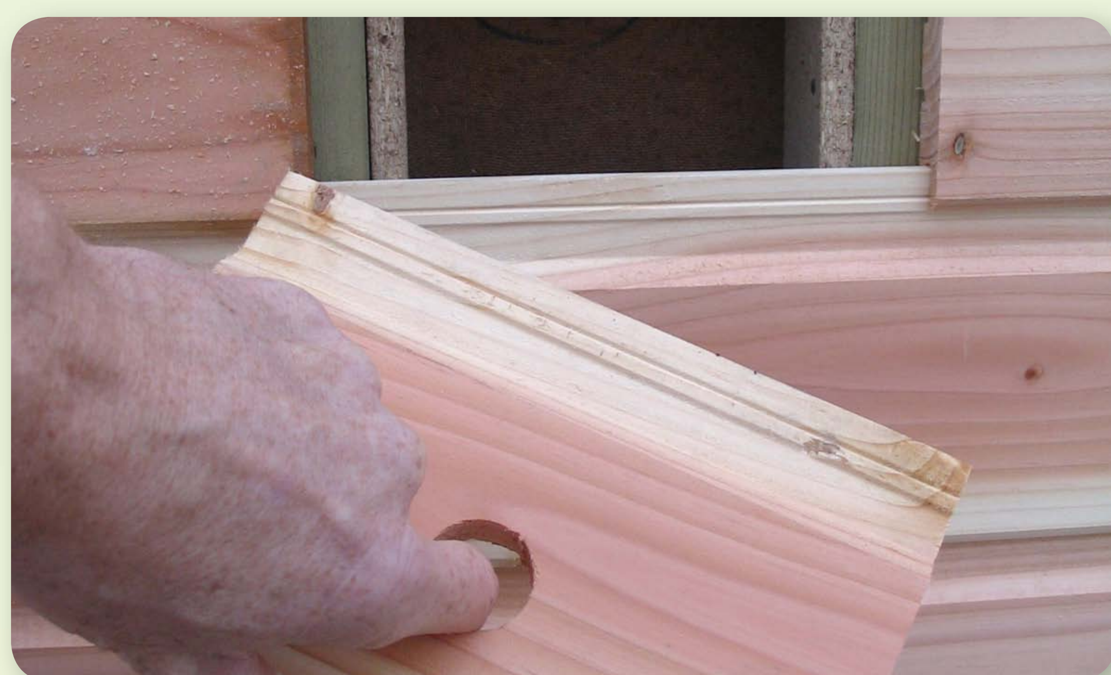
Nichoir intégré dans un bardage bois © LPO Vienne
