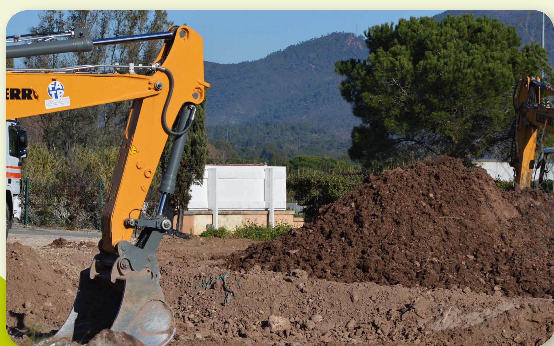
Travaux de terrassement © Fotolia
