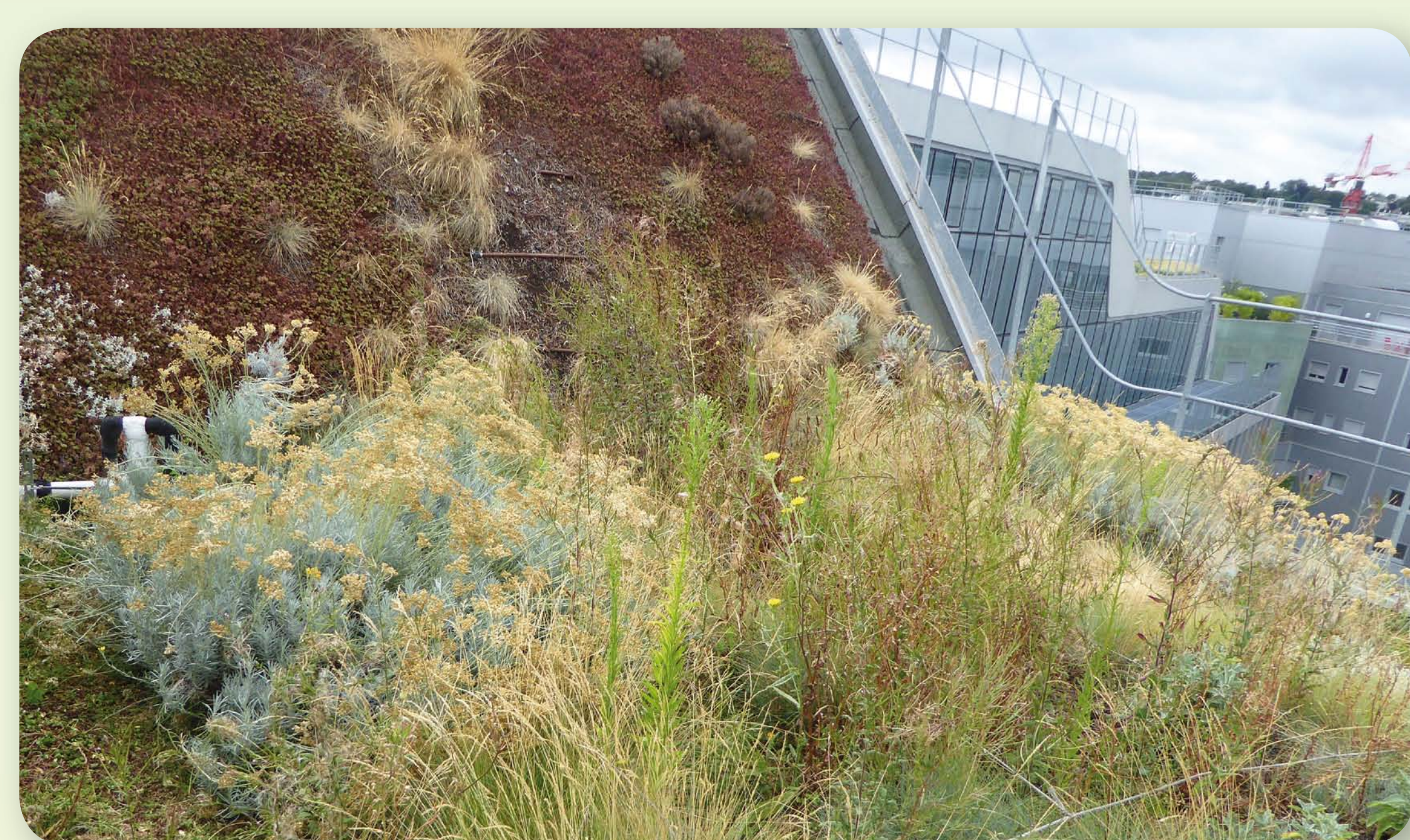
Quadra, immeuble Anthos à Boulogne-Billancourt (92) © Gecina
