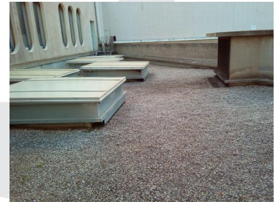
*Une toiture 100 % gravillonnée aux charges structurales limitées (120 kg / m<sup>2</sup>)*
