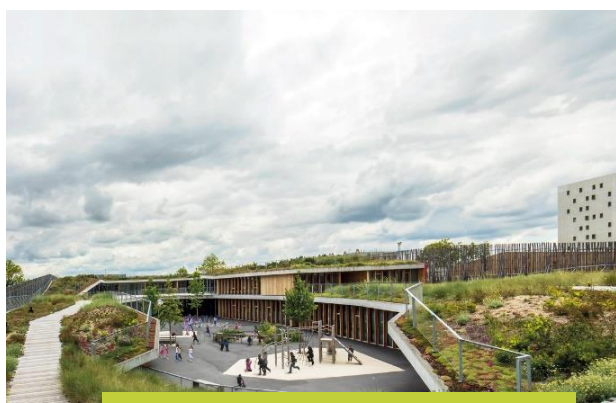
Toiture végétalisée du pôle enfance Aimé Césaire ©PHYTOLAB
