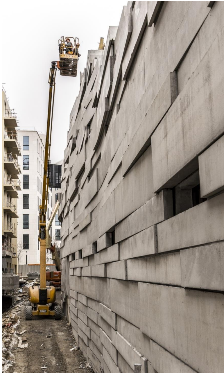
Pose des blocs
