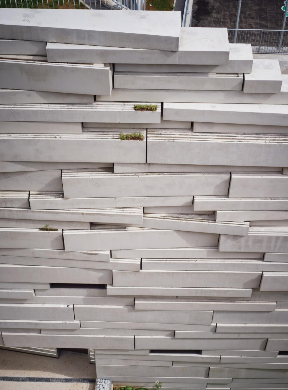
Les blocs spéciaux : blocs nichoirs
