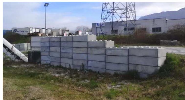
*Rampe d'accès consolidée à l'aide de blocs béton non-jointifs*
