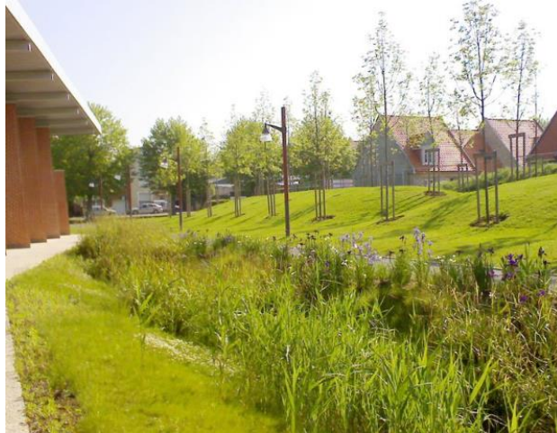
Planter une noue végétalisée
