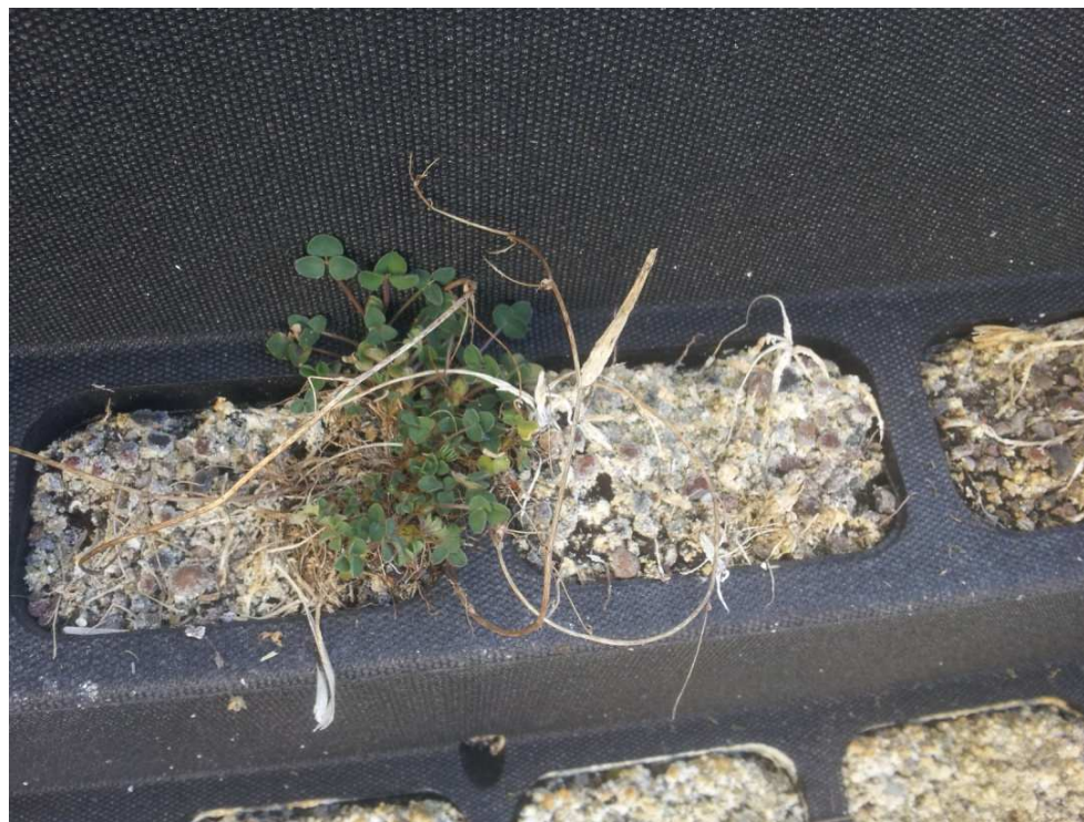
Mars 2013 – Démontage des modules
